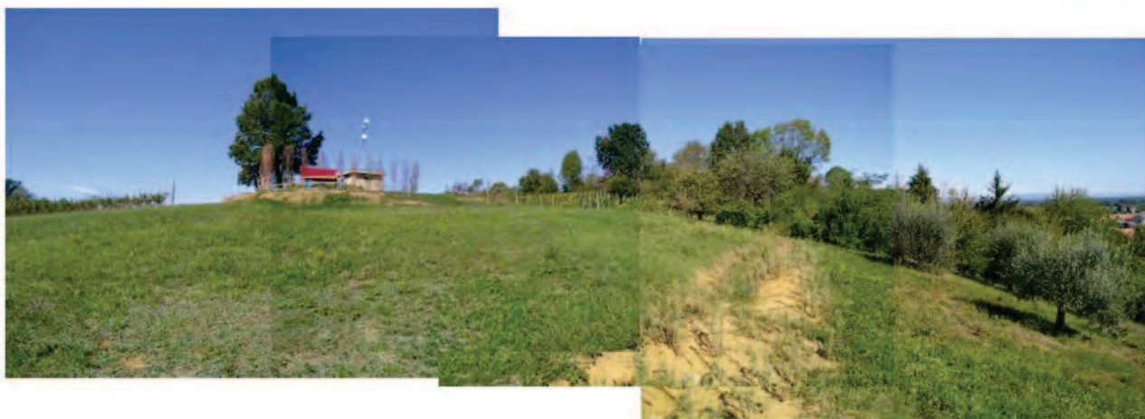
Dettaglio della foto precedente; nell'area alberata sullo sfondo è presente un recapito delle acque meteoriche verso valle
