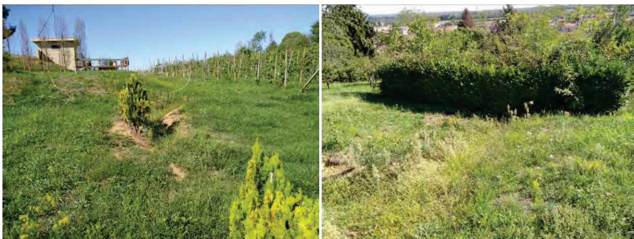
Regimazione delle acque meteoriche sul lato nord dell'intervento (a sinistra) ed inizio della vallecola (a destra)
