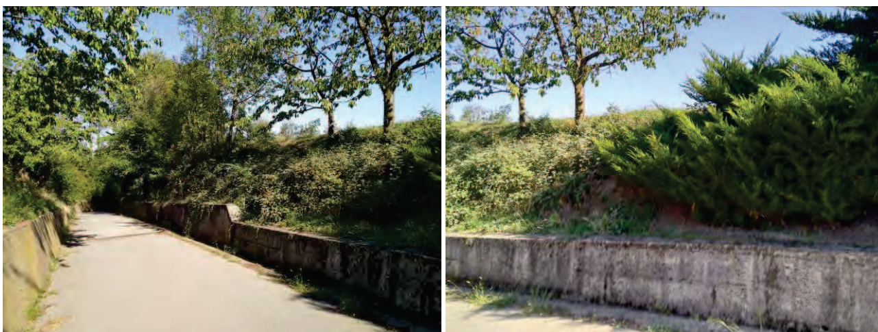
Muro di sostegno di controripa e scarpata stradale
