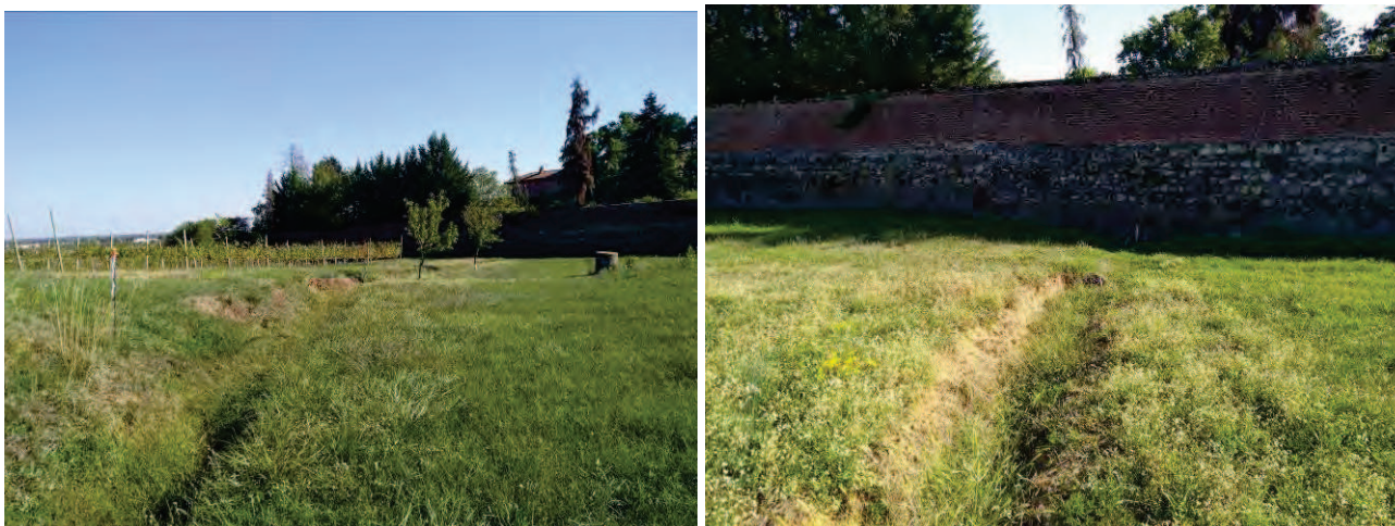
Regimazione delle acque meteoriche sul lato ovest dell'intervento (a sinistra), con recapito all'interno della recinzione del castello (a destra)
